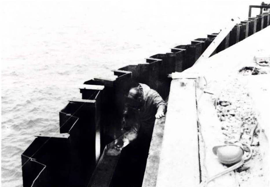
Udbygning af kongekajen 1986.
