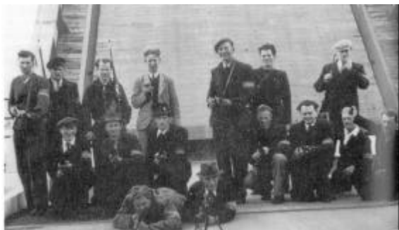
Den hævede broklap ved Aggersund spærrer for trafikken, og modstandsfolk fra Klim kontrollerer efter 5. maj 1945 passagen.
